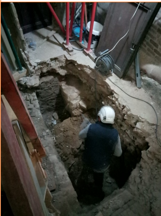
Foto 14. Desmuntatge dels murs UE 5 i 6.
