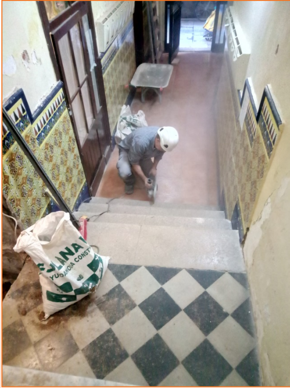
Foto 1. Inici dels treballs.
