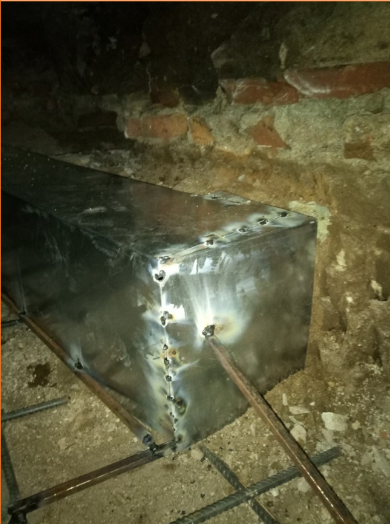
Foto 19. Vista de la coberta metàl·lica del mur UE 20.
