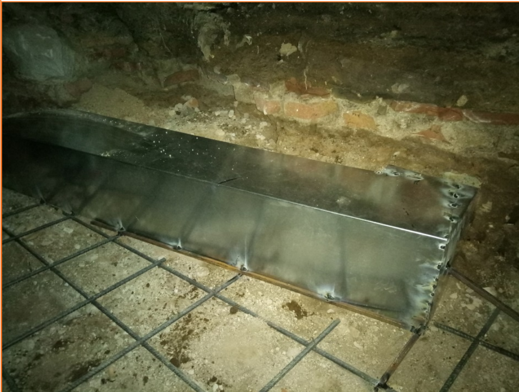
Foto 18. Vista de la coberta metàl·lica del mur UE 20.
