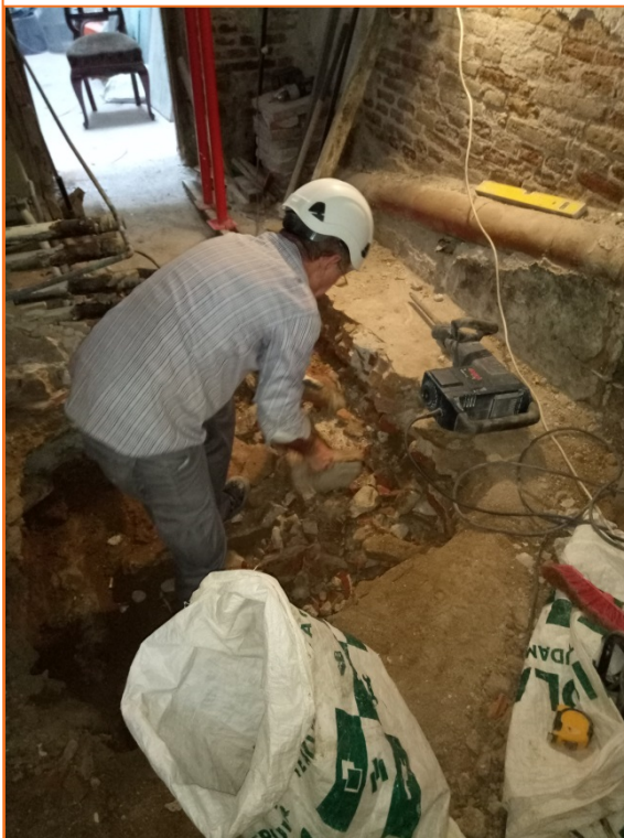
Foto 4. Desmuntatge de la canalització (UE 15).
